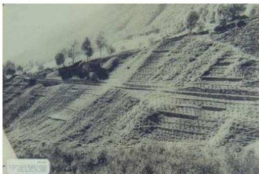
Alcune immagini storiche relative alle opere di sistemazione idraulico-forestale della Val Grande (sponda di Sotgur) eseguite mediante tecniche di ingegneria naturalistica a cura della Milizia Nazionale Forestale nel 1933 (Fonte Archivio CFS Brescia)
